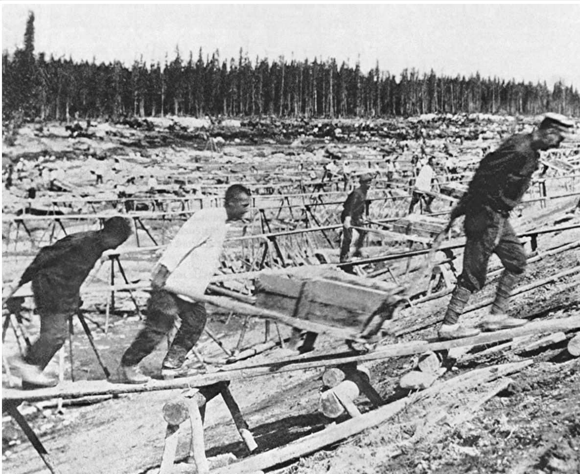
Zwangsarbeiter beim Bau des Weißmeer-Ostsee-Kanals (Belomorsko-Baltiyskij kanal). Der Kanal wurde von Oktober 1931 bis August 1933 auf Anweisung Stalins im Zusammenhang mit dem ersten sowjetischen Fünfjahresplan mit Hilfe Zehntausender Häftlinge des Gulag-Lagersystems der Geheimpolizei OGPU erbaut. Fotograf: unbekannt, ca. 1932. Quelle: Wikimedia Commons, public domain
