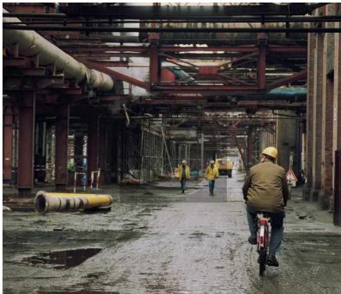
Paul Glaser: Leuna Abriss 1994. Hier entstand Anfang des 20. Jahrhunderts die deutsche Groß-Chemie. Jetzt ist das Werk heruntergekommen und wird zum größten Teil abgerissen. Das Gelände wird verschiedenen Firmen zur Ansiedlung dienen.
